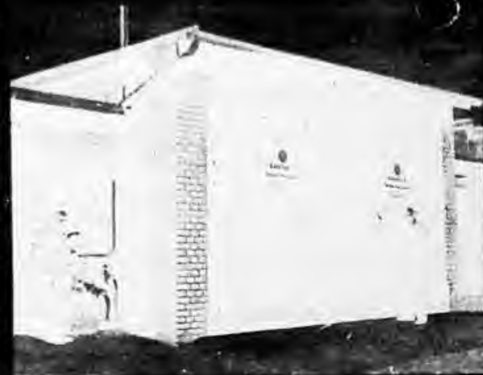
Abb. 9. „Gasschleuse“ in Schokoladenfabrik mit DEGESCH-Kreislaufanordnung.
